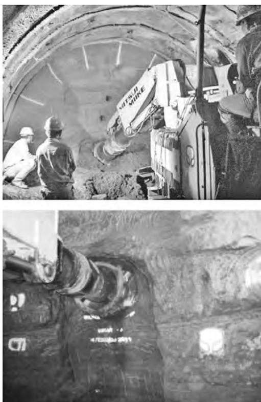
写真—2 ロードヘッダーによるトンネル掘削と貫通の瞬間
