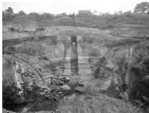
写真—3 汎用機械によるダム基礎掘削
