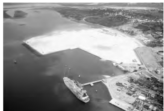
写真-7 海上作業終了時の現場状況
