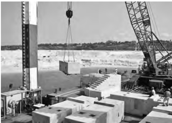
写真-5 ブロック据付状況
