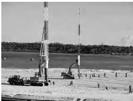
写真—3 PVD打設状況
