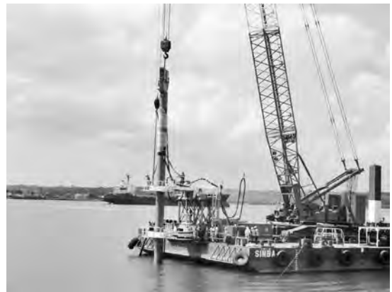
写真—4 鋼管杭打設状況
