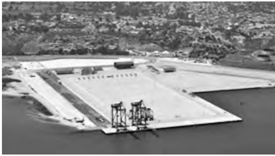
写真-8 コンテナターミナル完成写真
