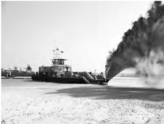
写真—2 埋立砂散布状況
