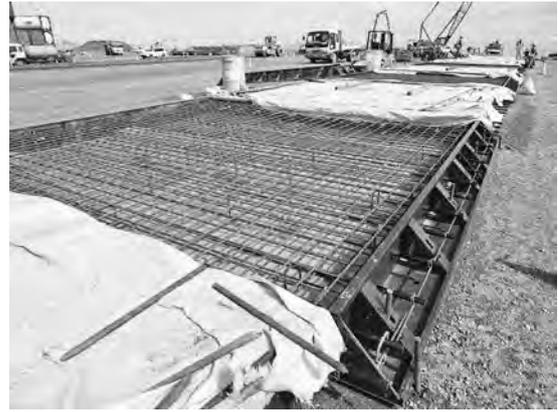
写真—16 舗装用型枠
