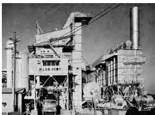
写真 4-4 NP3000A 形アスファルトプラント
