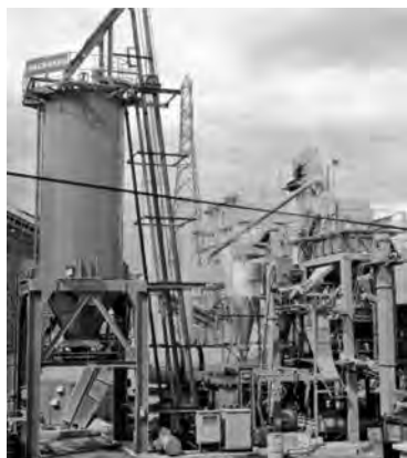
写真 4-8 日進建設（京都）に合材サイロを納入
