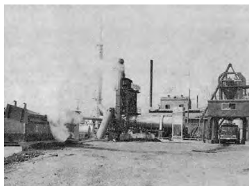
写真 4-16 NRP 302 リサイクルプラント
