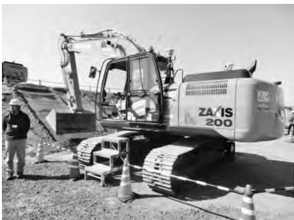
写真—3 バックホウマシンコントロール
