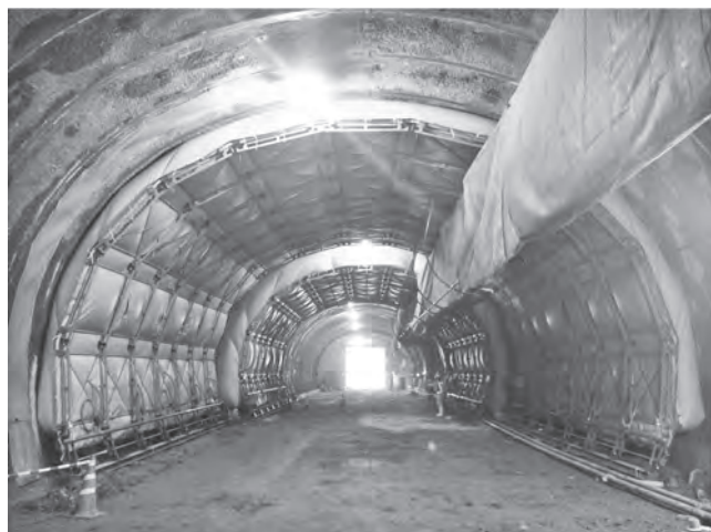
写真—1 ノイズカットバルーン設置状況
