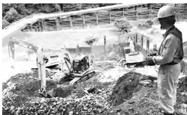
写真—1 バックホウの遠隔操縦による無人化施工
