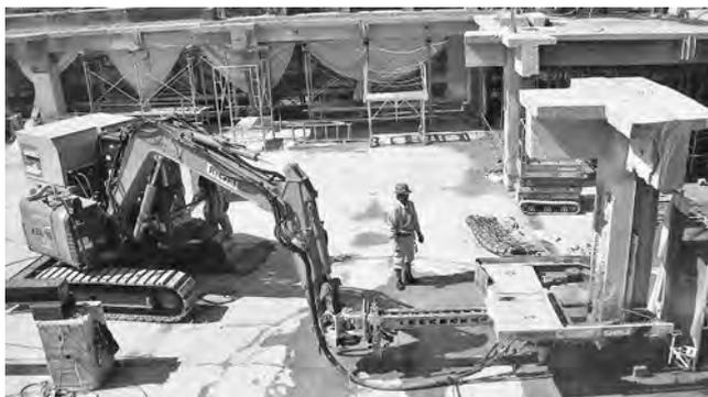
写真一 9 柱の切断
