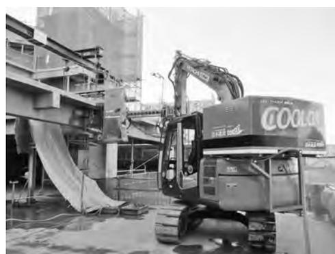
写真-7 大梁の切断状況
