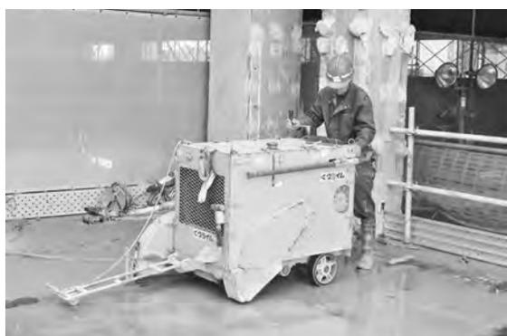
写真-5 道路カッターによる床版切断
