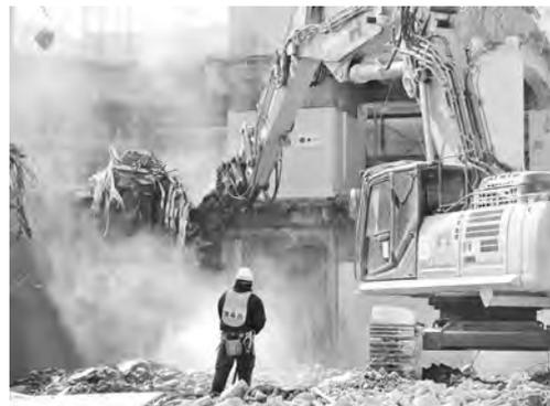
写真—2 従来の破碎による解体作業の状況
