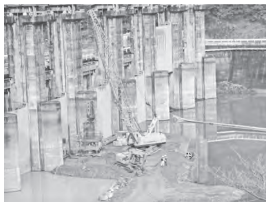
写真—1 オールケーシング掘削状況(全景)
