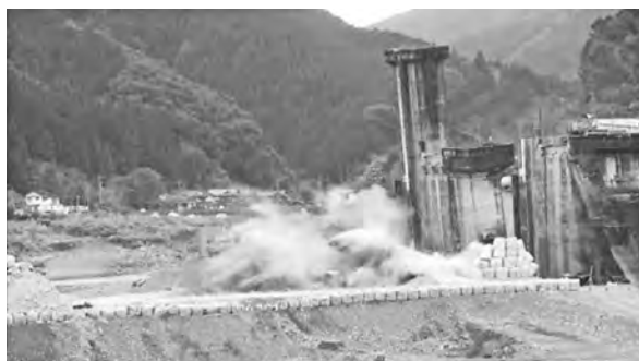
写真—3 P2 倒壊発破 発破の瞬間
