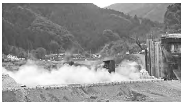
写真—4 P2 倒壊発破 倒壊の瞬間
