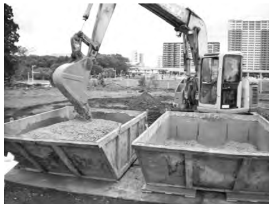
写真一八 バックホウによる攪拌混合
