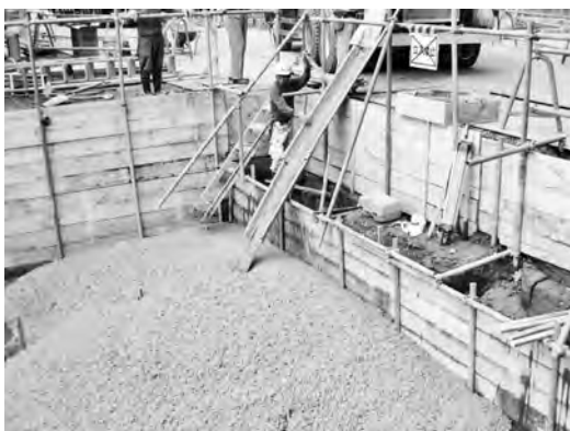
写真一3 本流動体の打設状況
