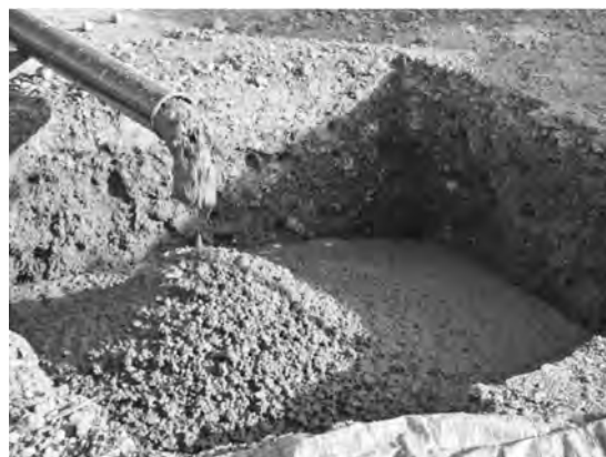
写真一九 配管打設の状況
