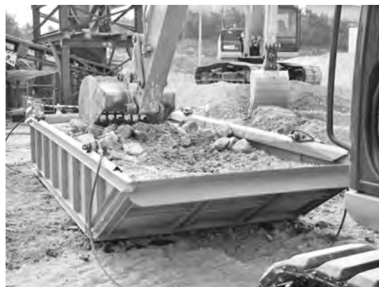
写真一5 粗粒材と本流動体の混合状況
