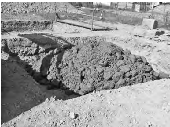
写真一六 粗粒材混合流動体の打設状況
