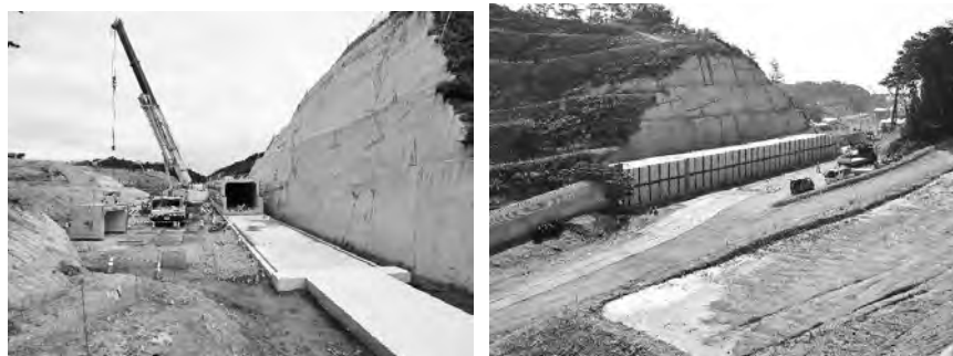
写真一9 ボックスカルバート設置
