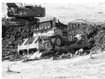
写真—2 大型重機による掘削・積込・運搬状況
