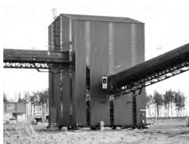
ベルトコンベヤカバー及び乗継部の建屋
