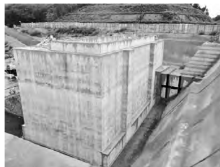
写真一12 階段室躯体
