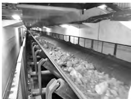
写真一10 ボックスカルバート内の土砂搬送状況
