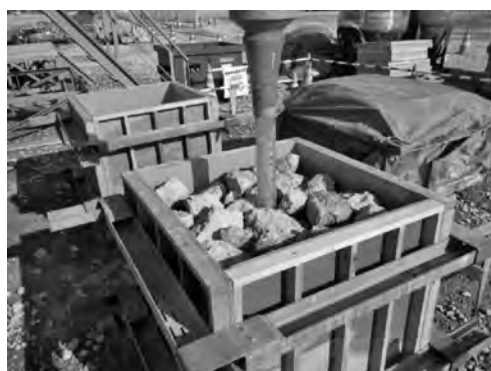
写真—7 ブロックの作製状況 (プレバックド工法)
