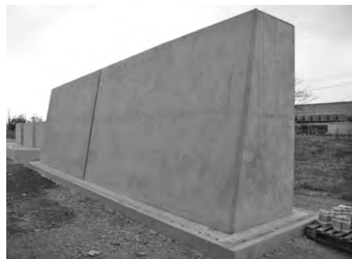
写真一九 防潮堤の完成後外観
