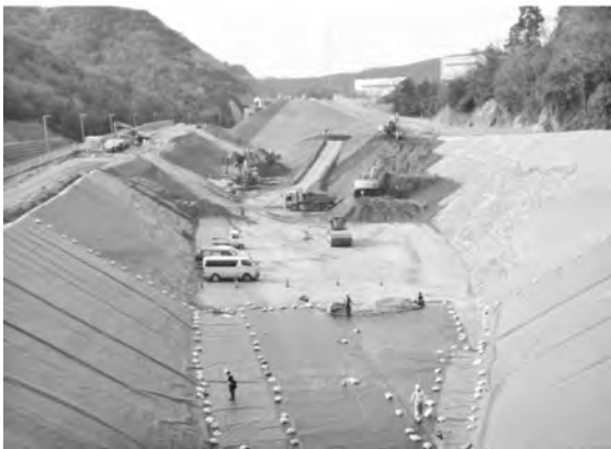
写真―3 遮水層施工状況
