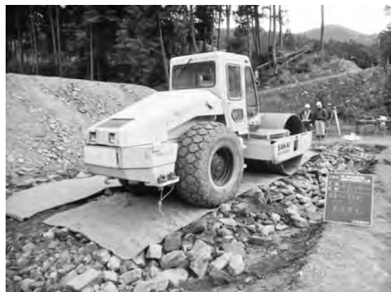
写真一2 遮水層破断確認試験
