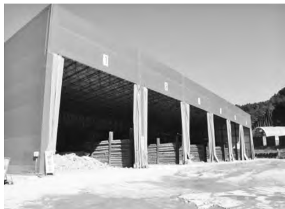
写真—1 掘削ズリ仮置き場
