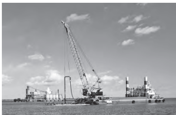
写真—4 施工状況（1F 起重機船打設）
