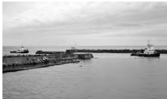
写真—2 施工状況（2F→1F 土運船海上運搬）
