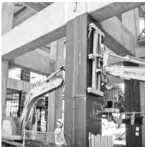
写真一2 鋼板巻き立て補強工法（重機を用いた施工）
