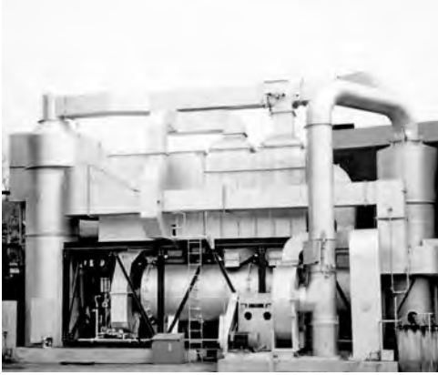
写真 4-31 TEC-R 型脱臭設備
