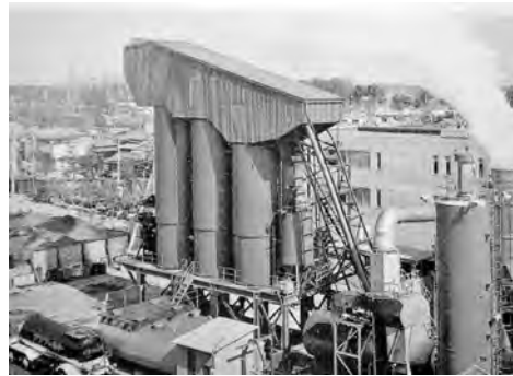
写真 4-22 バーバーグリーン社製 80 t/h ドラムミキシングプラント 大宮合材工場
