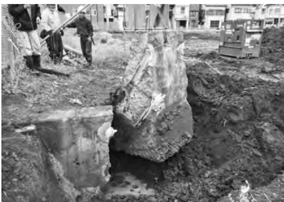
写真—2 解体した擁壁の撤去状況
