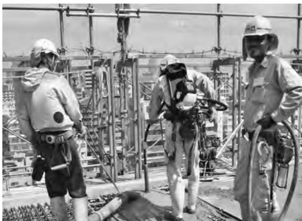
写真—1 バックパック式バイブレータ
