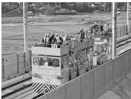
写真—11 電車線延線作業
