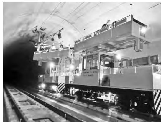
写真—8 架線作業車（昇降旋回作業床付）
