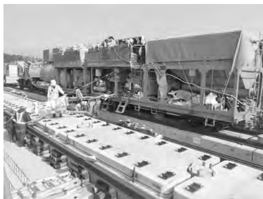
写真一 3 モルタル注入車
