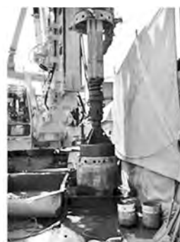
(b) ケーシング掘削
