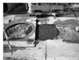
(d) 浄化壁打設完了
