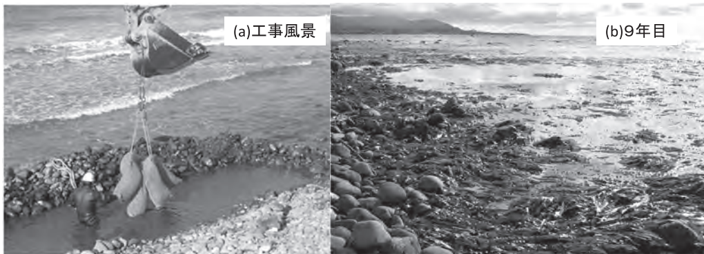
写真-3 鉄分供給ユニットの施工事例 1)
