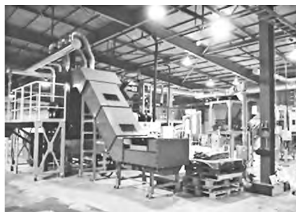
写真—1 破砕・選別設備の外観
