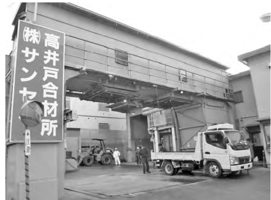
写真 5-15 地下式サテライトプラント
