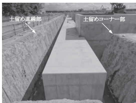
写真—2 直線部及びコーナー部土留め壁
