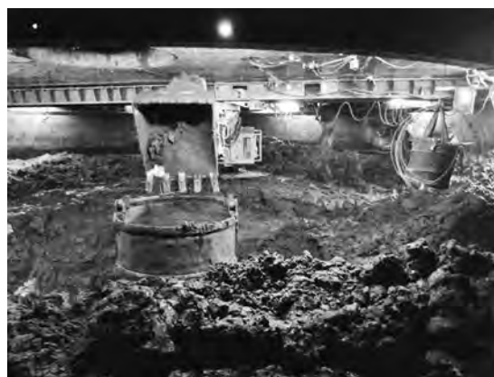
写真ー３ 作業室内掘削状況
