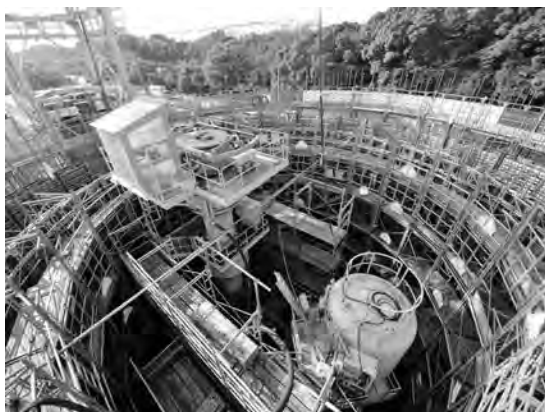
写真ー２ 立坑構築状況
