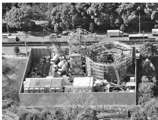
写真ー１ 立坑構築状況全景
