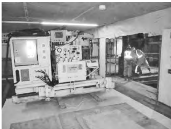
写真—3 フォークリフトによる超低空頭機運搬
