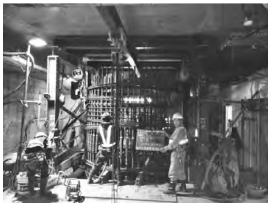
写真—7 鉄筋かごの吊り込み状況
