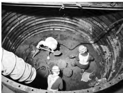
写真－1 深礎工法
