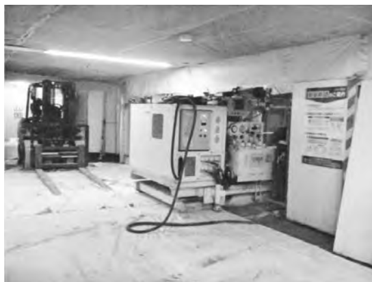
写真—4 スライドジャッキを利用した自走
