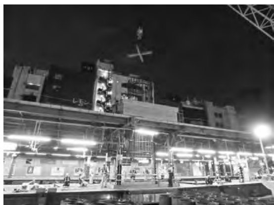
写真—10 鉄筋かごの吊り込み状況
