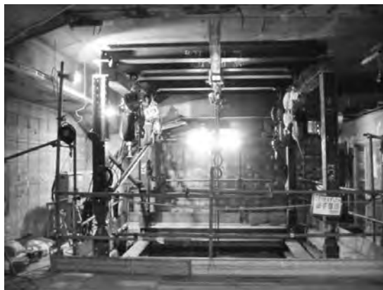
写真—6 吊り込み架台
