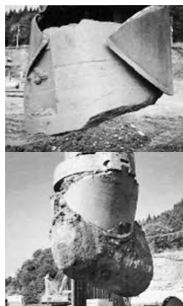
写真—3 ハンマグラブで破砕・把持した岩盤・転石
