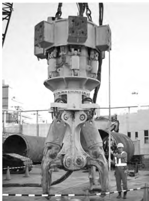
写真一十 本工法施工機 φ 3,000 mm 級 吊り下げ状況
