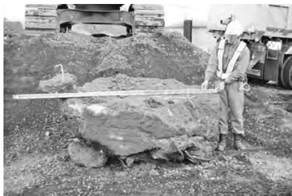
写真一十一 撤去された2mを超える鉄筋コンクリート
