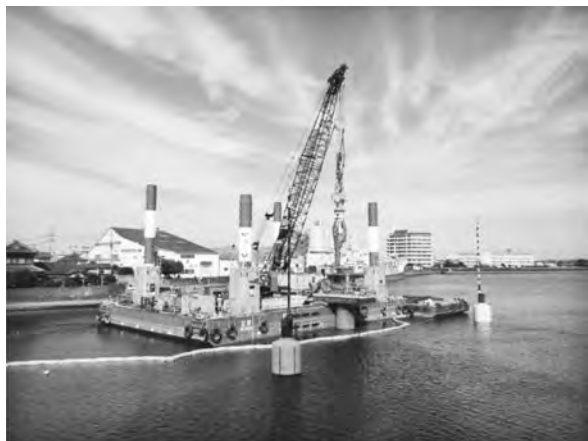
写真—17 SEP 上から実施する本工法
