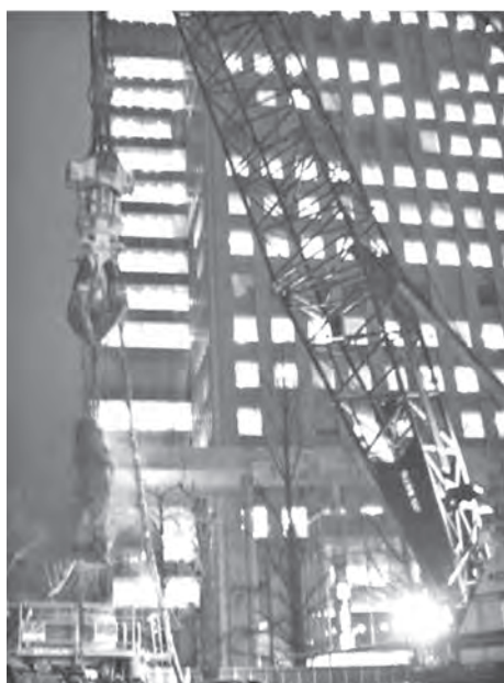
写真—13 本工法施工機の夜間施工
