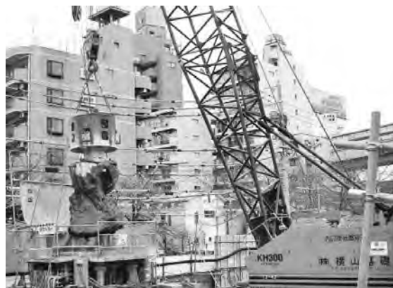
写真－7 油圧グラブによる障害物の排出状況
