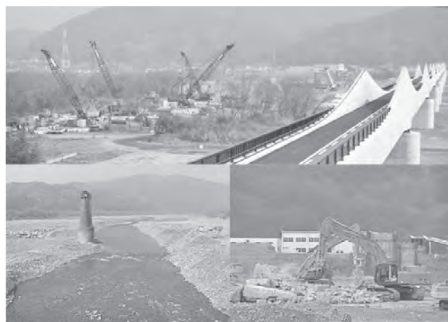
写真—14 某河川内の旧橋脚撤去の現場
