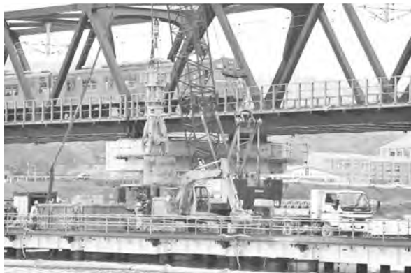
写真—16 旧鉄道橋基礎撤去工事
