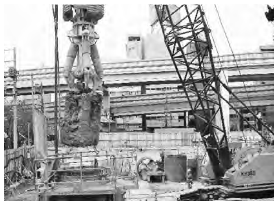
写真－6 本工法施工機による障害物の排出状況
