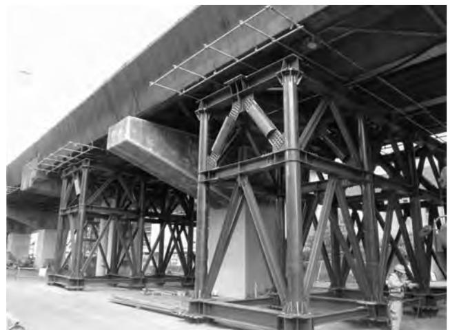
写真—5 鋼製仮受け構造完成
