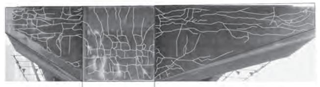
図-3 東下P44梁部のひび割れ状況
