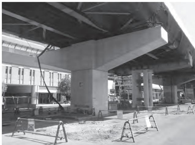
写真一八 再構築橋脚
