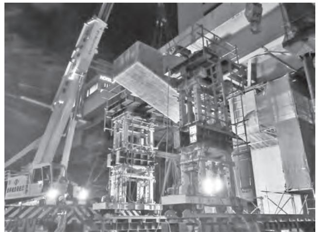
写真—7 切断ブロック搬出作業
