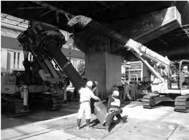
写真—3 鋼管杭取り込み状況
