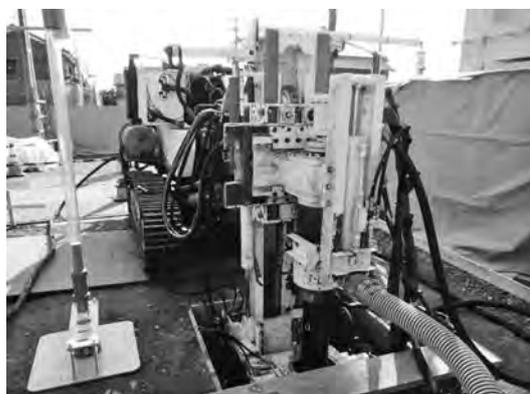
写真—7 鋼管杭削孔状況
