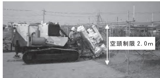
写真一3 施工機移動状況
