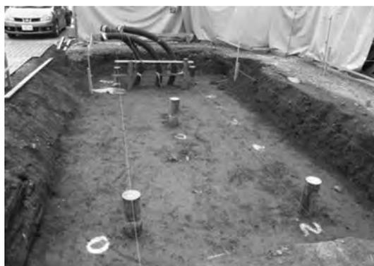
写真—8 鋼管杭打設完了状況
