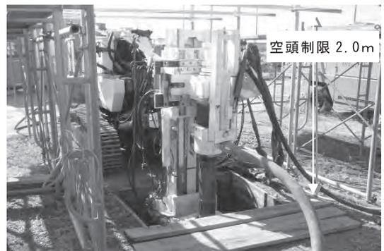
写真一4 乾式削孔試験状況
