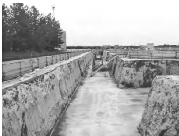
写真一四 掘削・均しコンクリート打設完了
