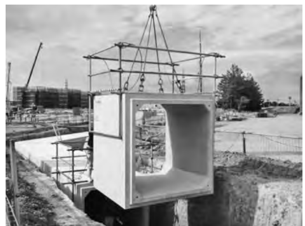
写真一六 プレキャストカルバート設置状況
