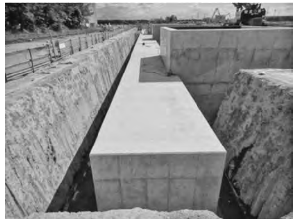
写真一五 現場打ちカルバート設置完了
