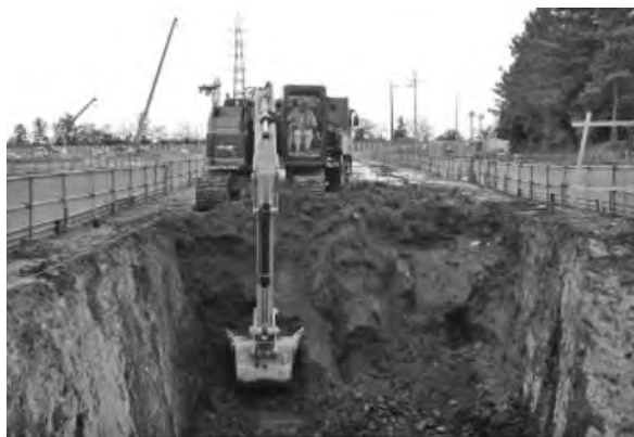
写真一三 土留め内部掘削
