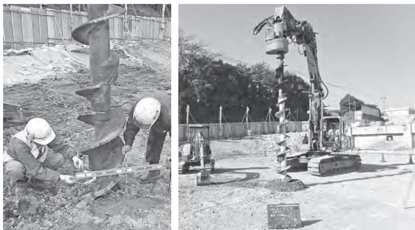
写真一 8 締固め施工状況
