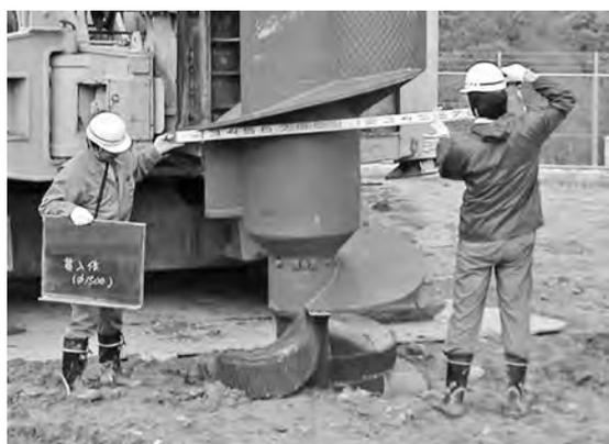
写真一2 貫入体 ( $\phi 900$  mm,  $\phi 1,500$  mm)
