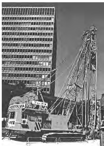
写真—1 クローラ搭載 水平多軸式掘削機
