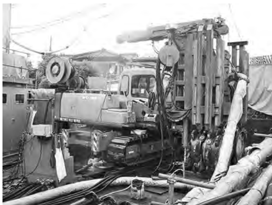
写真—9 直打式施工
