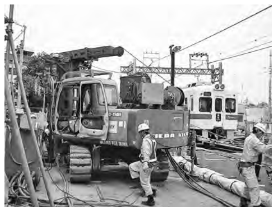
写真—10 斜打施工 姿写真
