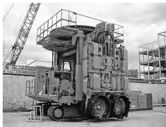
写真—2 MRD型低空頭槽台車搭載 水平多軸掘削機
