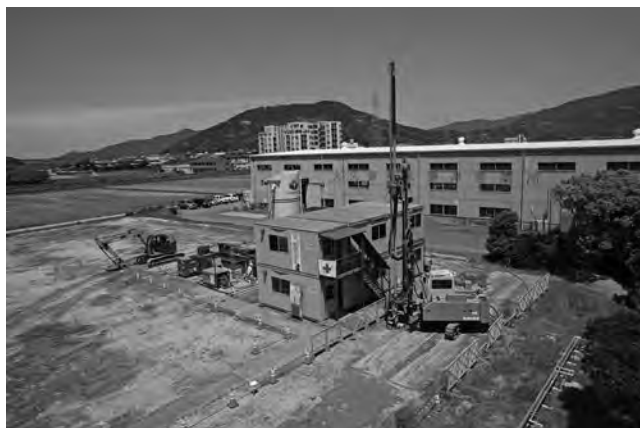
写真—1 試験施工状況
