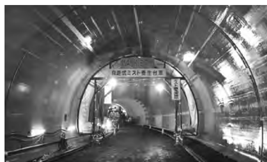
写真—1 WALK ミスト工法適用状況（瀬目トンネル）
