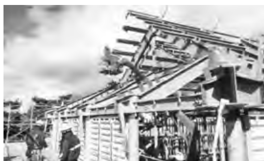
写真一 5 妻面鉄骨組立状況
