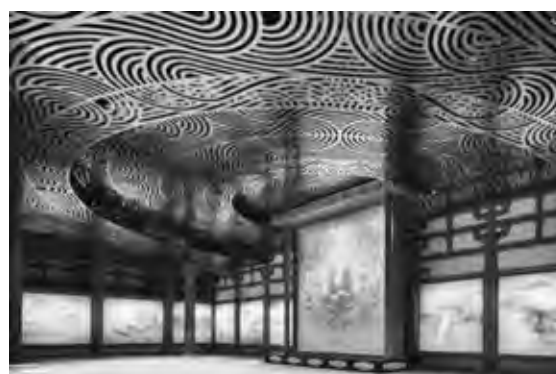
写真—8 完成写真（内観）
