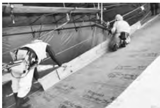
写真一 6 現寸図型板による屋根曲面確認状況
