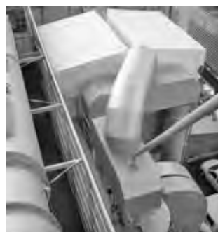
写真 6-25 バグフィルタ2基設置状況
