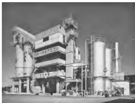
写真 6-9 TAP-2030E 型 アスファルトプラント
