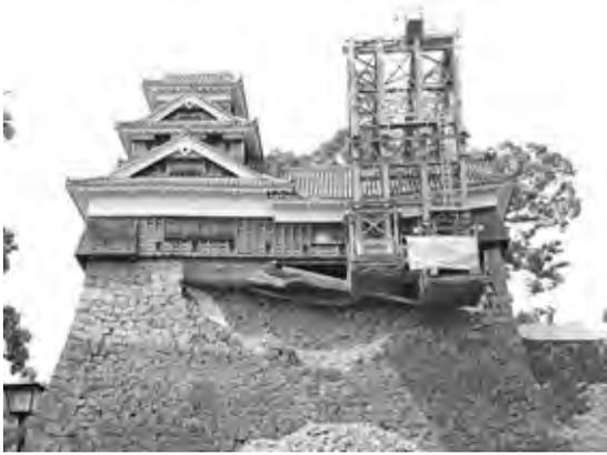
写真—17 櫓を支えるように床下に差し込まれた「鉄の腕」
