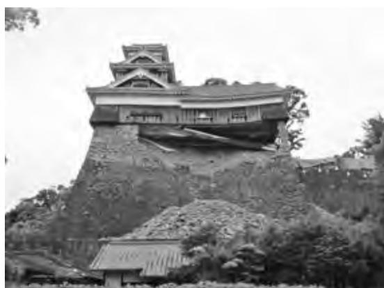
写真—2 地震により石垣が崩れ落ちた南面
