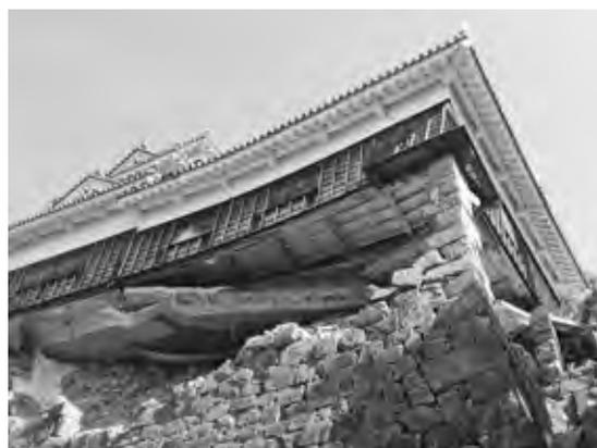
写真—3 頑丈な木組みが屋根や内部を支え櫓の崩壊を免れた
