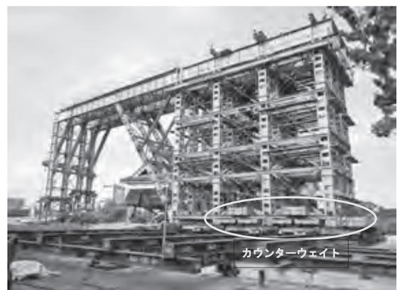
写真-5 架台全景（架台約220t+カウンターウェイト200t）
