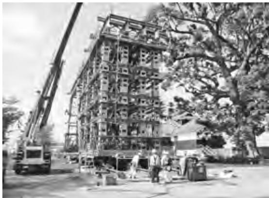
写真一11 架台組立完了スライド開始前全景
