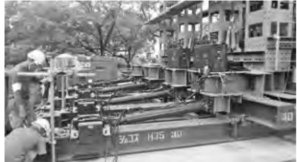
写真一九 押引複動型H鋼クランプジャッキ
