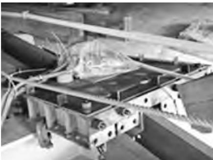
写真—19 グラウトパックで床下の隙間を微調整
