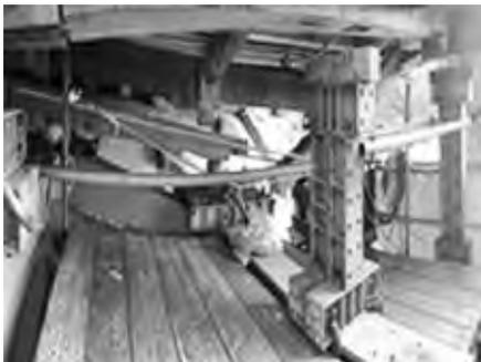
写真—18 受梁と床下の隙間が一定になるように鉄骨で調整
