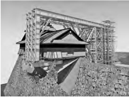
図一4 櫓を「鉄の腕」で抱え込むようにして倒壊を防ぐ（イメージ図）
