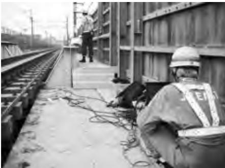
図一五 応力測定状況の一例
