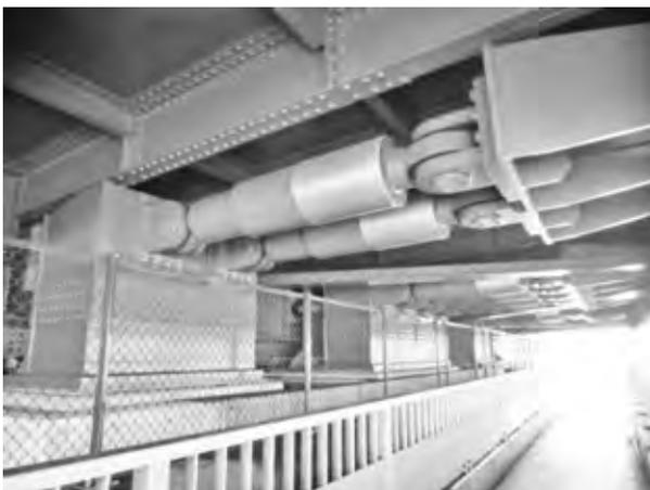
写真-12 清洲橋の制振装置
