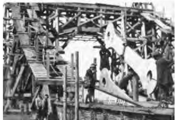
写真—8 清洲橋吊鎖アイバー架設状況
