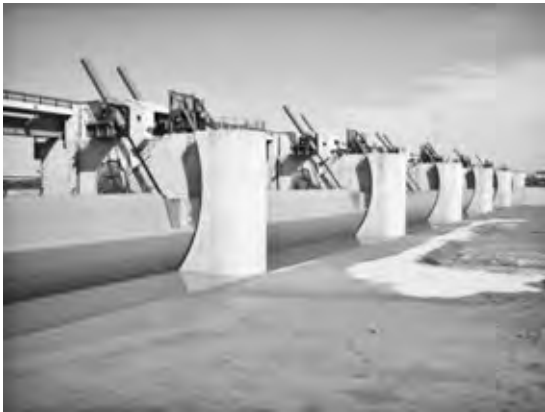
写真—5 扉体・開閉装置据付完了*1
