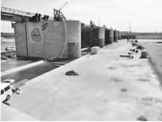
写真—4 基礎材・中心軸据付完了
