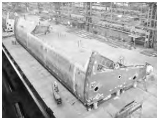
写真-2 調節下段扉仮組状況
