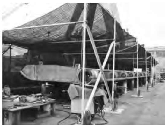
写真-3 調節上段扉仮組状況
