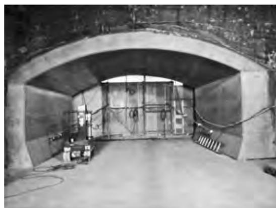
写真-4 レンガアーチ高架橋 (内巻き補強後)
