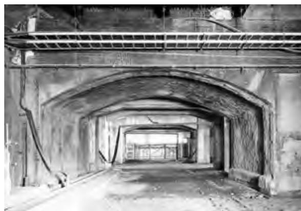
写真-3 レンガアーチ高架橋 (内巻き補強前)
