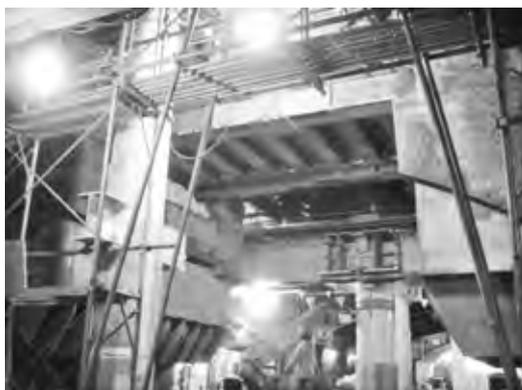
写真—2 アーチクラウン撤去完了
