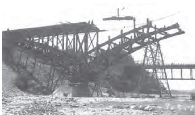
写真-3 架設状況
