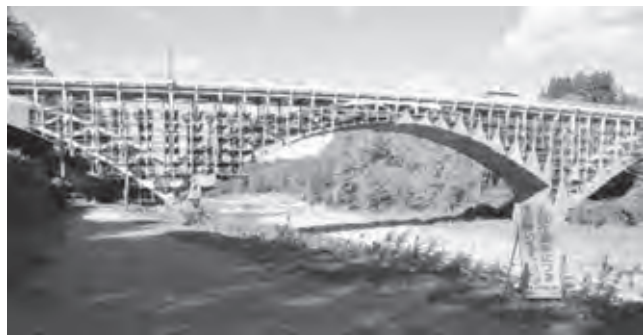
写真—1 工事中の晩翠橋
