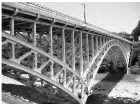
写真一8 完成した晩翠橋
