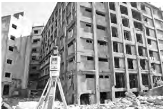
写真—1 3D レーザースキャナ計測
