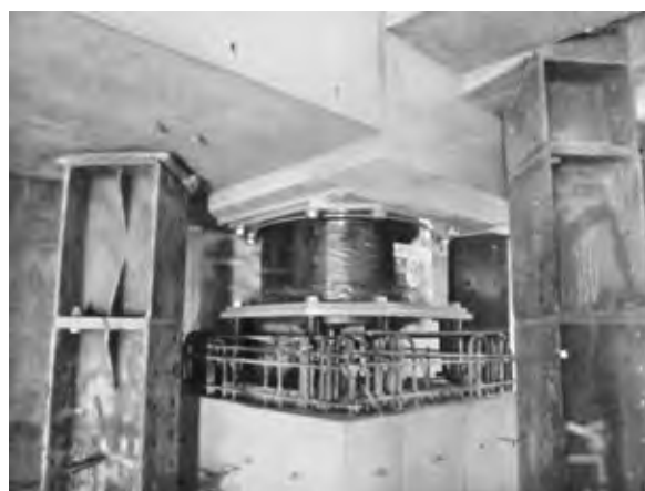
写真—7 免震装置設置状況
