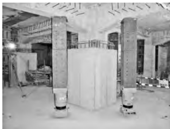
写真—6 地下1階ジャッキ設置
