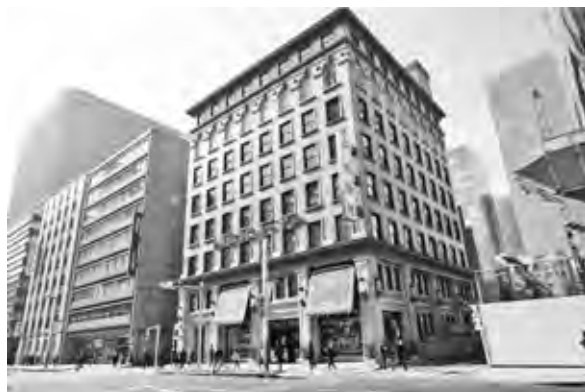
写真一 4 工事前の明治屋京橋ビル
