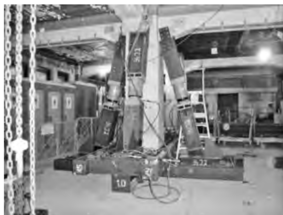
写真—5 地上1階ジャッキ設置
