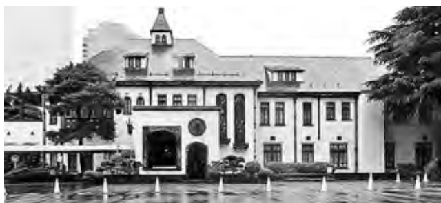
写真—1 工事前の旧李王家東京邸
