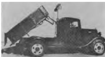
写真一46 矢野式ダンプ機構<sup>13)</sup>
