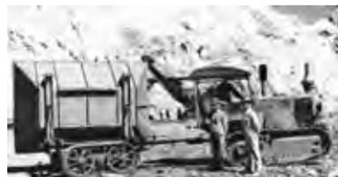
写真一49 横転式牽引クローラダンプ<sup>6)</sup>
