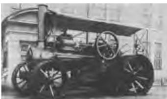
写真—30 蒸気トラクタ<sup>16)</sup>
