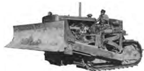
写真—33 内地唯一のブルドーザD7<sup>17)</sup>
