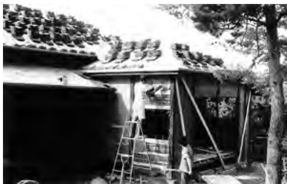
写真—5 移築工事中（森鷗外・夏目漱石住宅）
