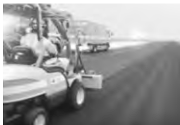
滑走路ゴム除去工事
