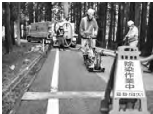
除染作業状況
