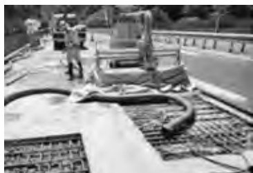
橋梁床版補修工事
