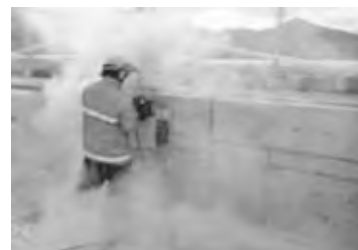
塗装剥離工事
