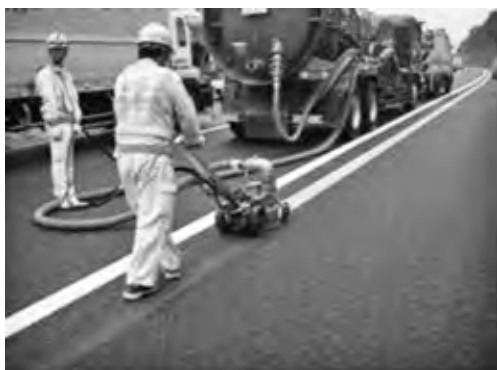
区画線消去作業状況
