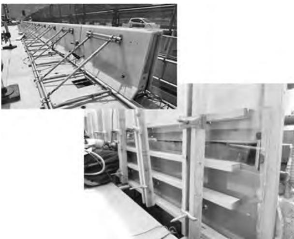
写真—7 PC壁高欄施工状況
