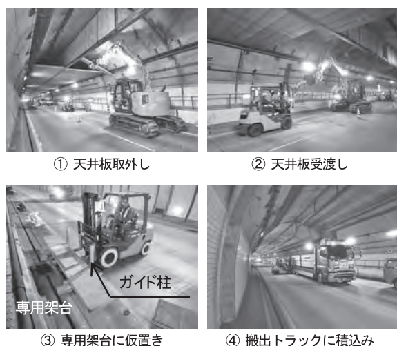
写真—5 天井板撤去作業の流れ
