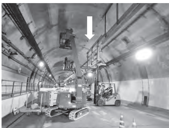
写真一 7 中央金具撤去状況
