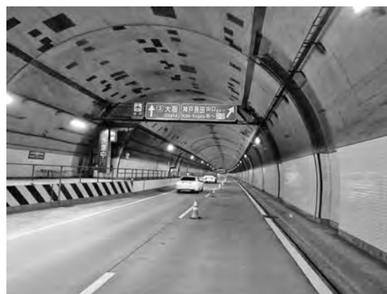
写真一 8 天井板撤去完了
