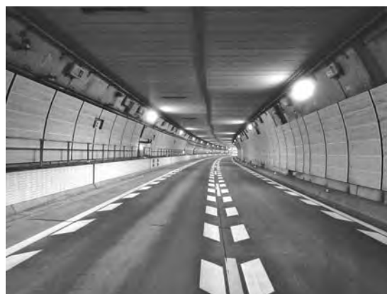
写真—1 天井板撤去前
