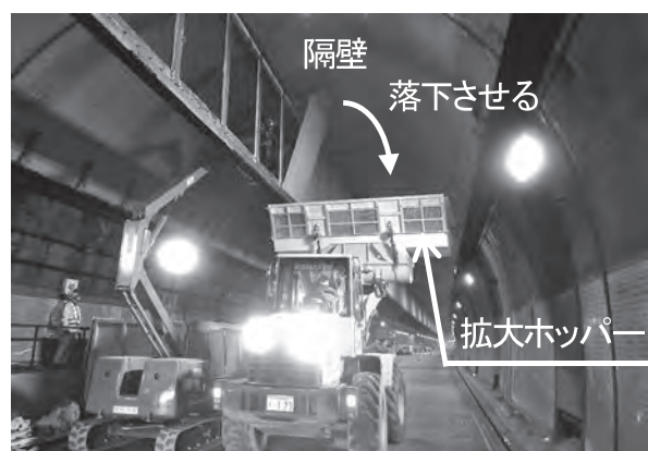
写真—6 隔壁撤去状況
