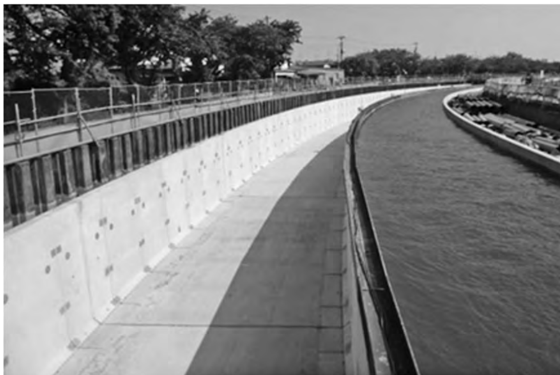
写真—8 プレキャスト水路完成
