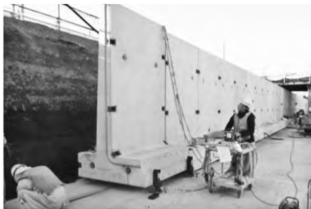
写真—6 設置状況
