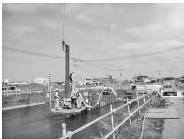
写真—2 半川締切鋼矢板圧入状況
