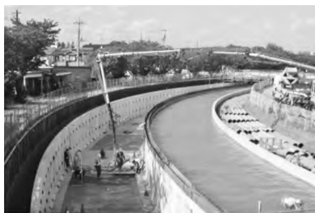
写真—7 底版打設状況
