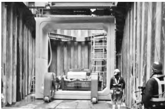
写真—10 運搬状況
