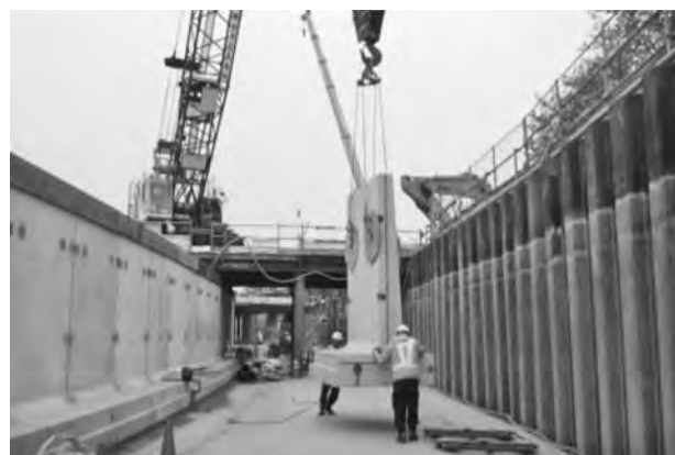
写真-4 荷卸し状況
