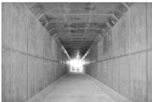
写真—11 BOX水路完成
