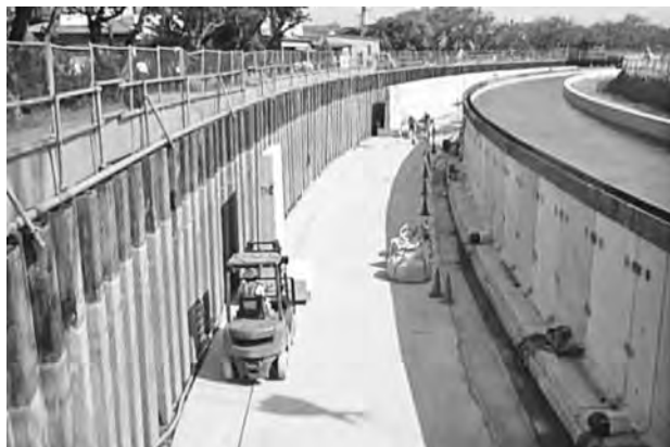
写真—5 横引き運搬状況
