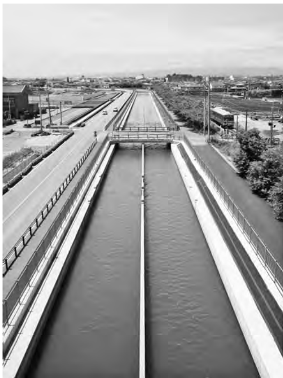
写真—1 武蔵水路（改築完了）
