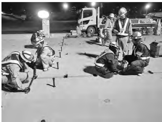
写真—18 コッター式継手本締付け状況
