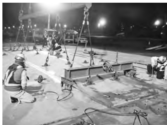
写真—12 地切り状況
