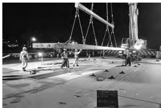
写真—13 既設PPC版撤去状況
