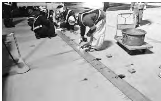
写真16 段差解消摺付鉄板設置状況
