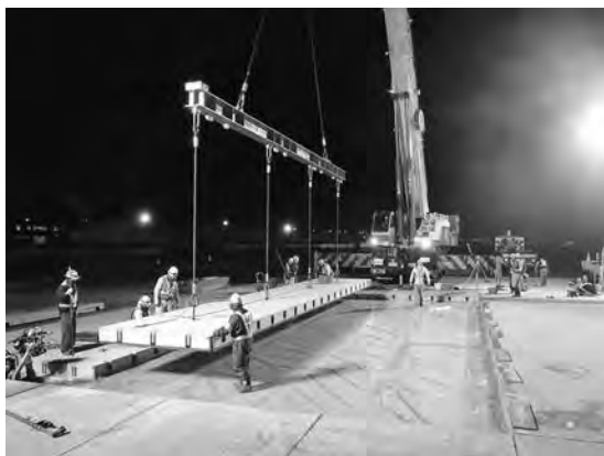
写真14 高強度 PRC 版設置状況
