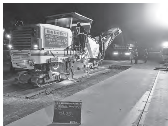
写真—11 路面切削状況
