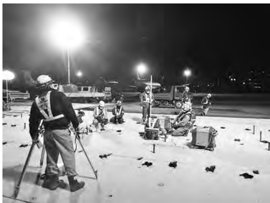
写真15 高さ調整状況
