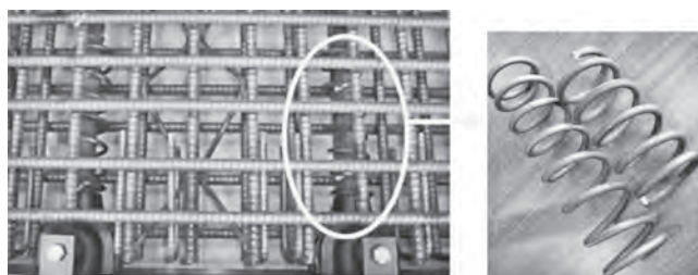
写真—8 スパイラル筋の配置
