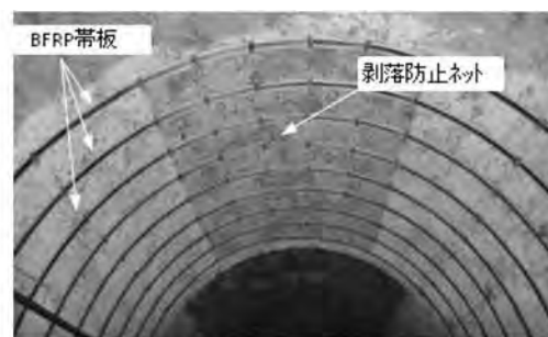
BFRP帯板接着による内面補強
